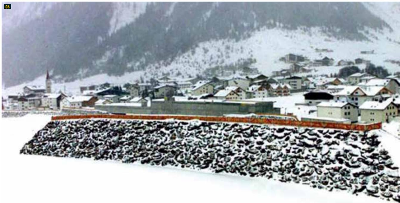
06 Der erste von zwei Schutzwällen in Galtür am Donnerstag, 17. Februar 2000, vor den größtenteils neu erbauten Häusern im Ort. Die Mauer ist 340 Meter lang, bis zu zwölf Meter hoch und aus vielen Tonnen von Stahl. © ap |
